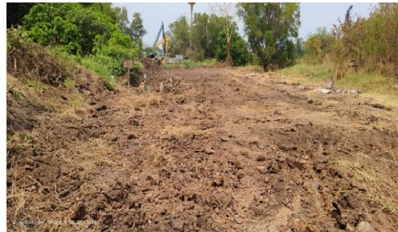
รูปที่ 2-6 การคืนพื้นที่ ปรับสภาพดิน ภายหลังการดำเนินการขุดย้ายท่อแล้วเสร็จ
