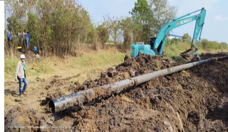
รูปที่ 2-8 ภาพการเก็บกองดินให้ห่างจากตลิ่ง
