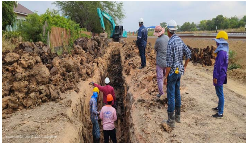
รูปที่ 2-9 ภาพการเปิดหน้าดินเฉพาะช่วงขณะทำการขุดย้าย
