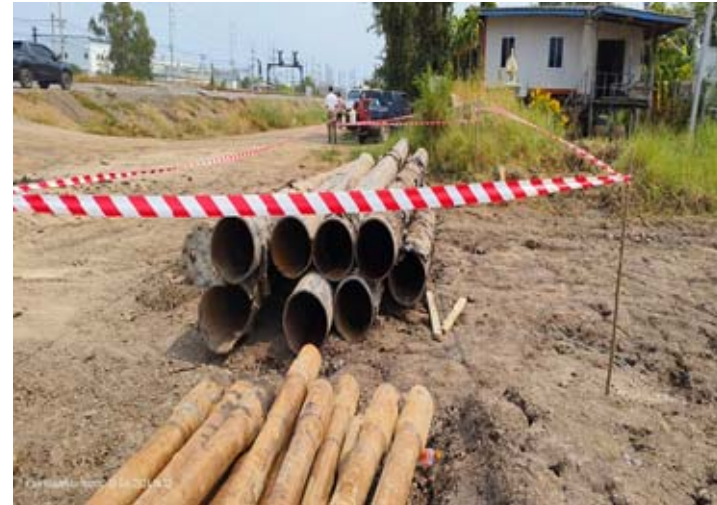
รูปที่ 2-10 การเก็บกองวัสดุอุปกรณ์ให้เป็นระเบียบ ไม่กีดขวางทางสัญจร
